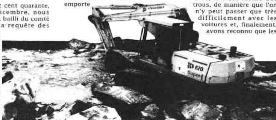
Enrochement de la Savoureuse à Giromagny en 1993 - Ph. F. Liebelin
