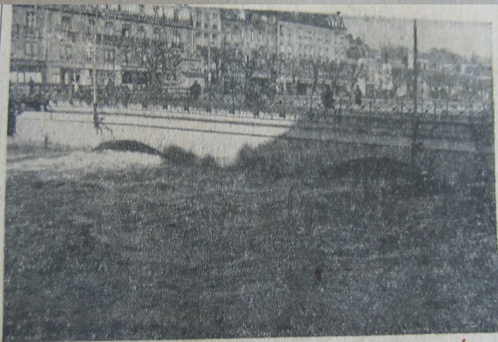
Encore cinquante centimètres et le flot tumultueux se serait brisé contre le pont. On imagine facilement la violence du courant en voyant les remous de la rivière
