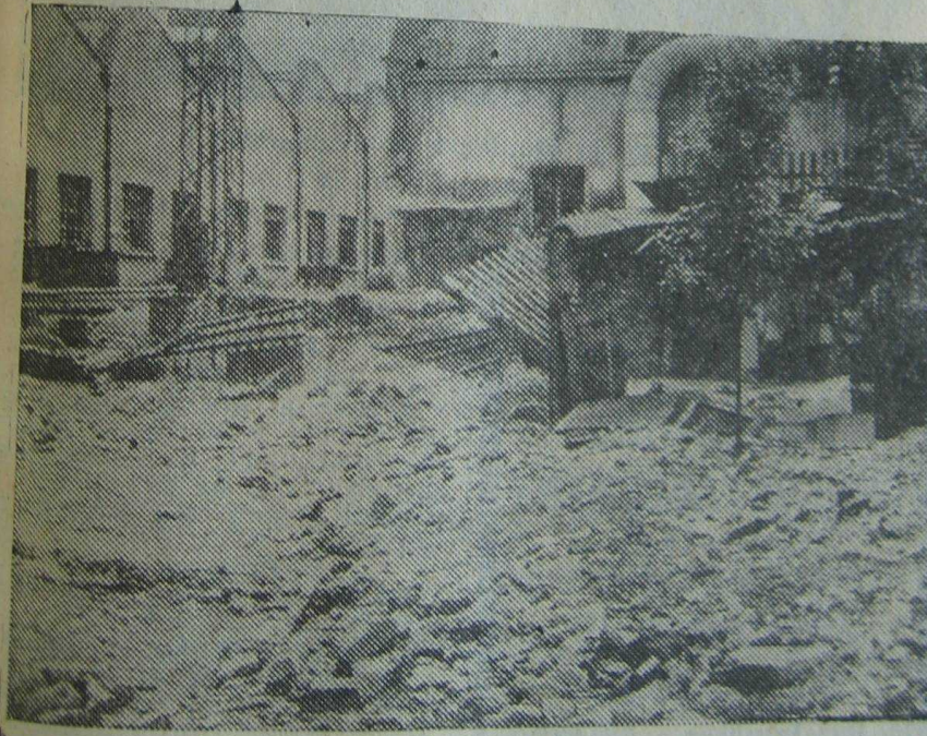
Après la tornade, voilà ce qui reste des jardins potagers dépendant des casernes « Sous le Bois » (Photo Dufay, Hérimoncourt)
