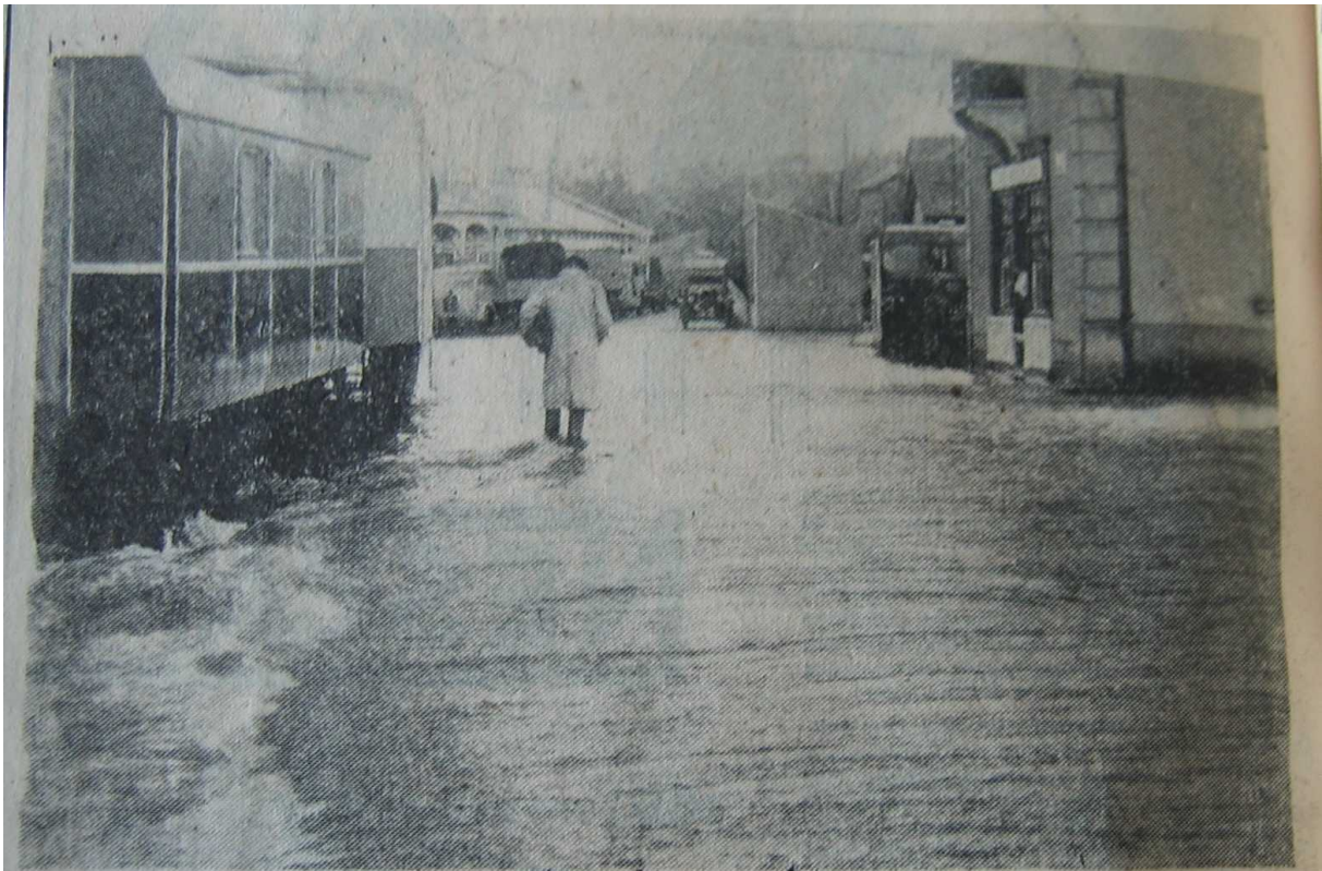
A Voujaucourt, sur la place de la fête, les roulettes des forains sont prises dans un torrent d'eau et de boue
