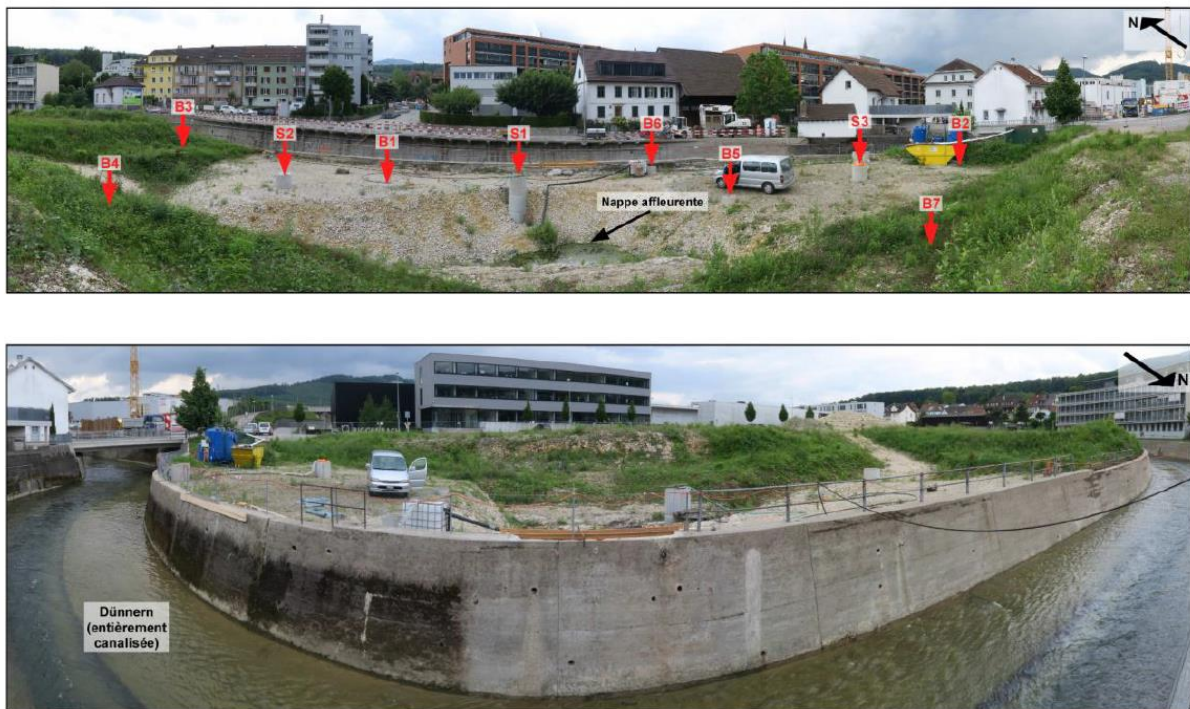
Figure 6 Photographies panoramiques montrant le site de Türler à Olten et la position des puits et forages utilisés pour le test de l'essai de pompage intégratif. Le forage B1 a été utilisé pour le pompage. Le suivi a été effectué dans les points marqués d'une flèche rouge sur la photographie (Tomson, 2016).
