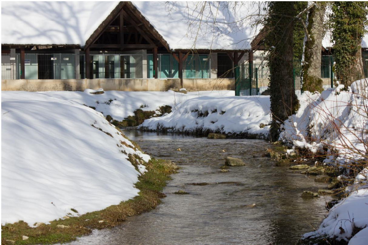
Figure 14 : vue du ruisseau de Fontenu, nettement sur-élargi et recalibré
