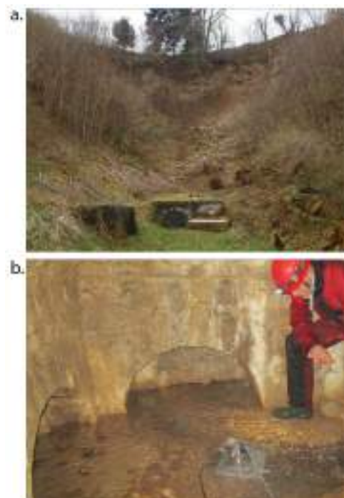
FIGURE II.14 – Captage de la source du Dahon (a) et fond du captage avec les arrivées d'eau (b)
