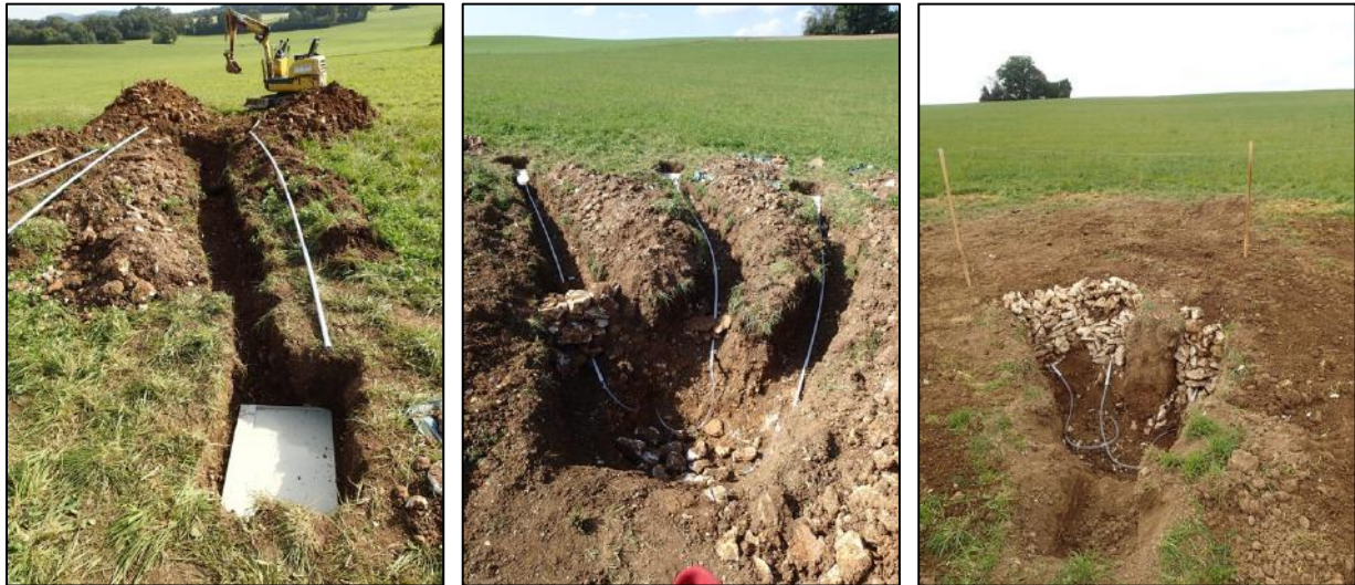
Figure 14. Étapes de l'installation de plaques lysimétriques. Clichés É. Lucot.
