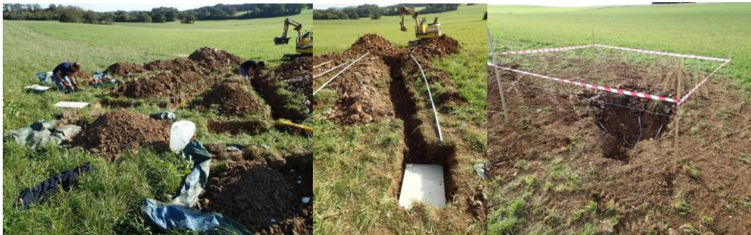
Figure 17. Travaux d'installation du dispositif de Plaisir Fontaine (crédit photographique, E. Lucot)
