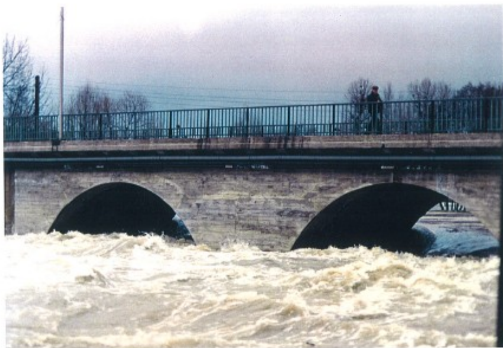
Pont du DOUBS vers la Mairie
