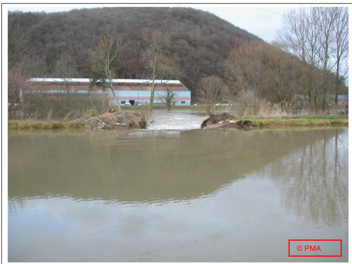
Brèche dans le canal
