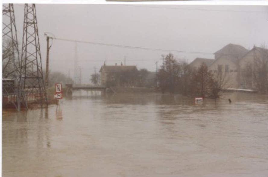
Aval de l'écluse 59 de St. Vit
