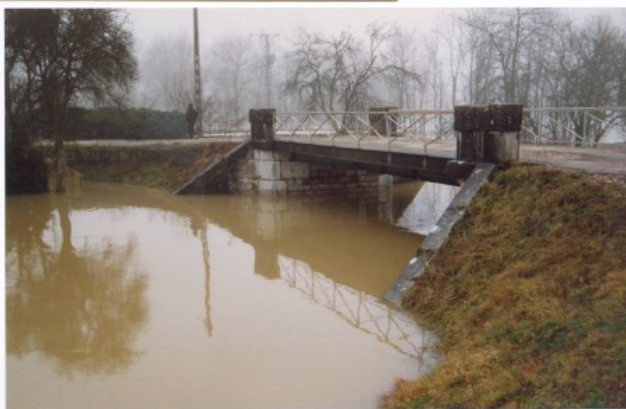
portes aval de l'écluse 59 de St Vit . même les barrages pour noyées
