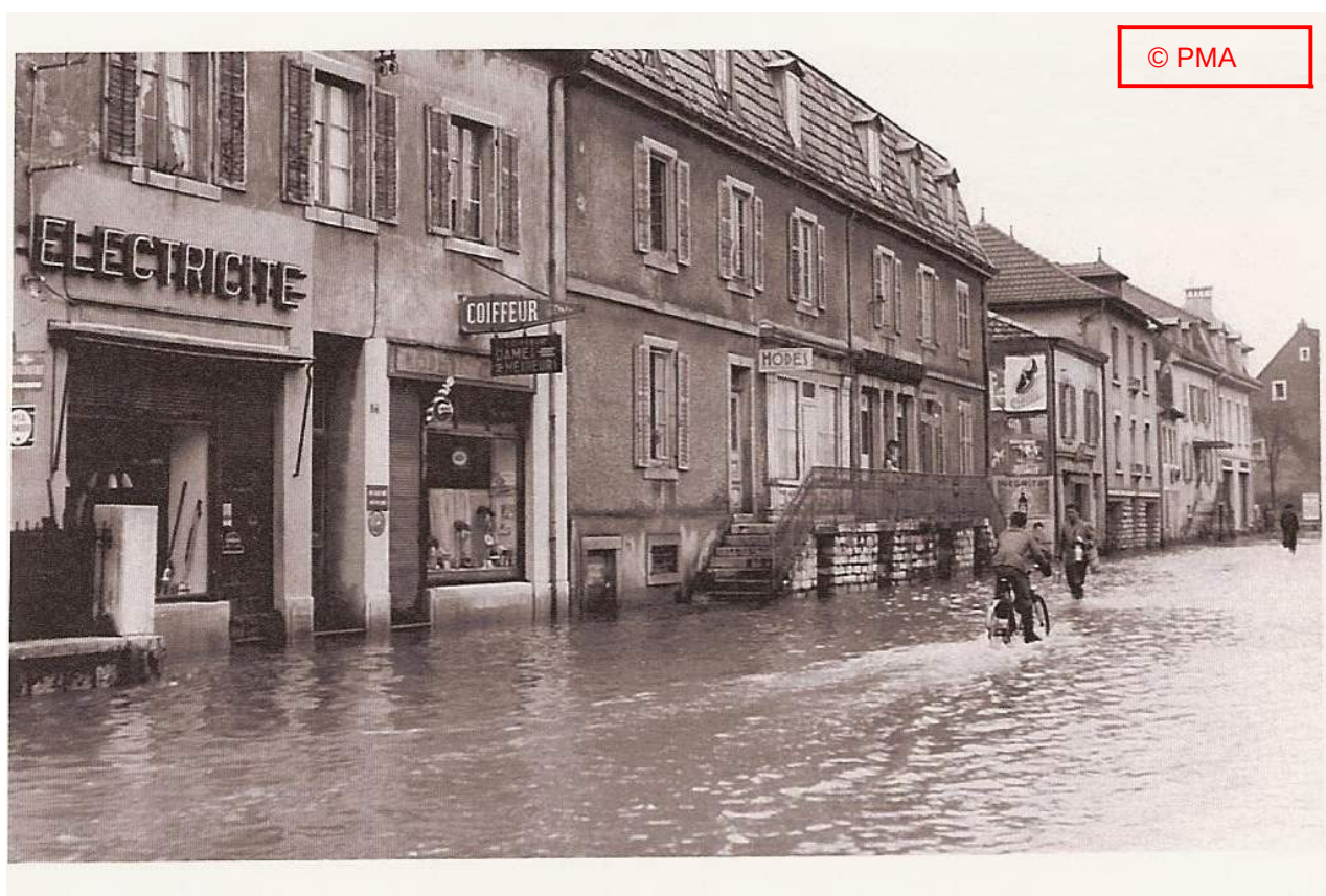
« Entreprise Nodelfer, Grande Rue »
