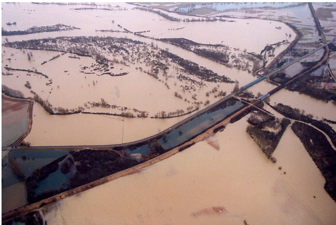
Vue du double pont SNCF / RD468, Chaussin
