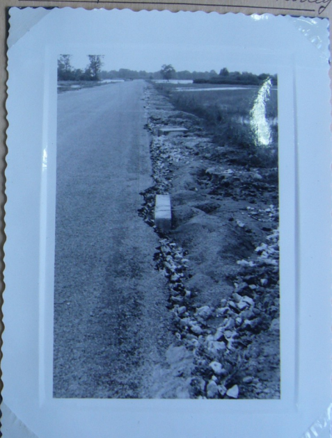
10- C.P. 331 - dégâts sur le nouveau chemin - enlèvement des accotements - dégradation à la
