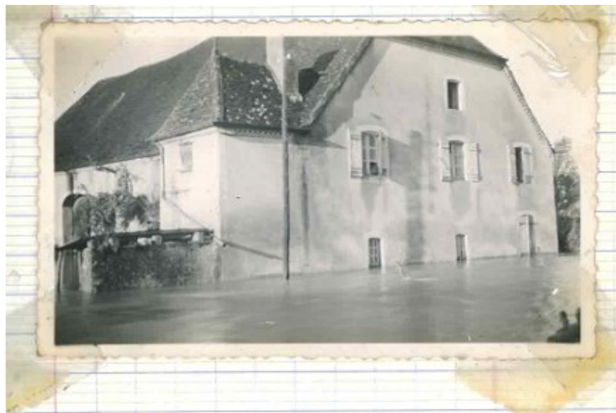
L'eau "entre" ou "ressort" par les fenêtres de la maison CALINON
