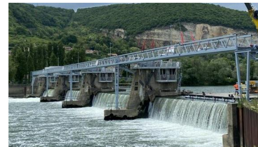
Figure 3 : Barrage mobile de régulation à Couzon sur la Saône (source VNF)
