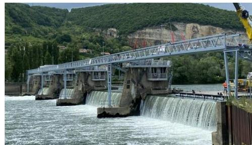
Figure 6: exemple de barrage mobile sur la Saône - le barrage de Couzon (source VNF)
