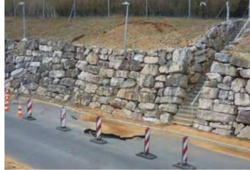
Vide sur chaussée et déformation d'un soutènement (12) - Cerema
