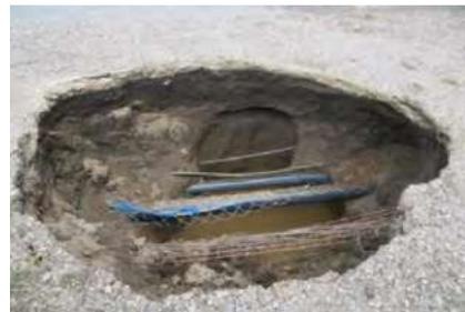
Canalisations proches de la rupture (45) - BRGM
