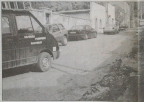
À Santenay, devant la salle des fêtes, la rue est défoncée
