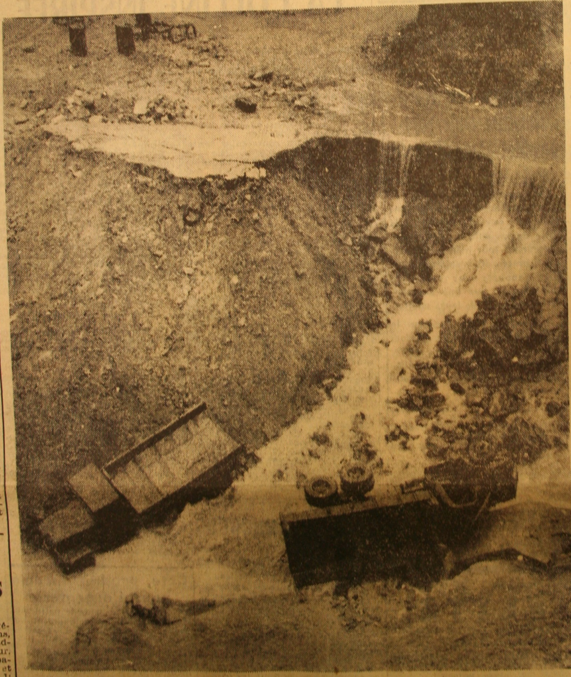
A la carrière « Lacoste », située à quelques kilomètres de Nolay, ces deux camions, emportés par les eaux, gisent au fond d'un ravin de 25 mètres
