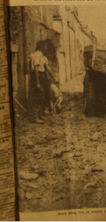
Dans cette rue, la couche de pierre et de gravier a plus d'un mètre de hauteur
