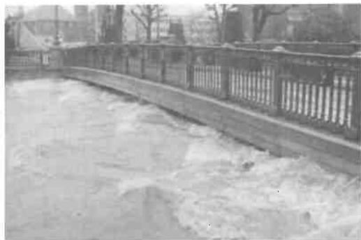
Ce récent ouvrage est soutenu par une très haute poutre d'acier, barrant la rivière sur environ un mètre de haut. On voit des vagues se créer, remontant le courant (qui s'écoule de gauche à droite).
