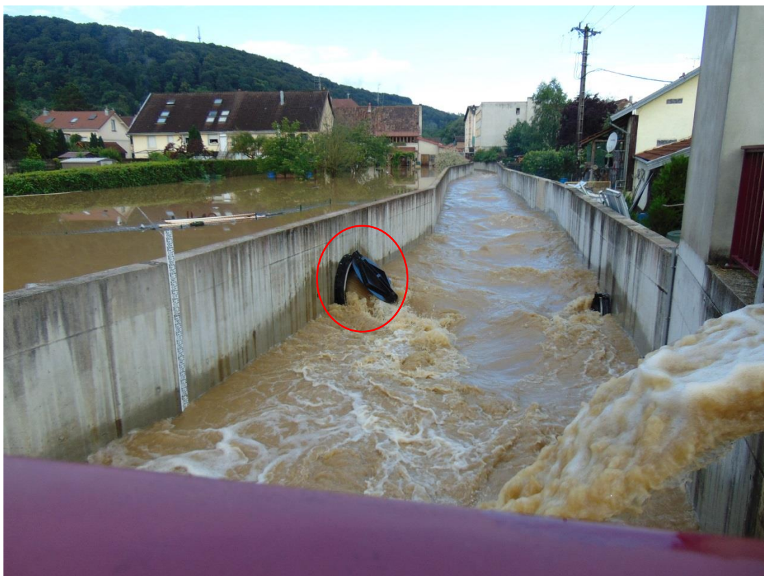
Rupt aval à la limite avec la digue de l'Allan (25/06 entre 6 et 7h)
