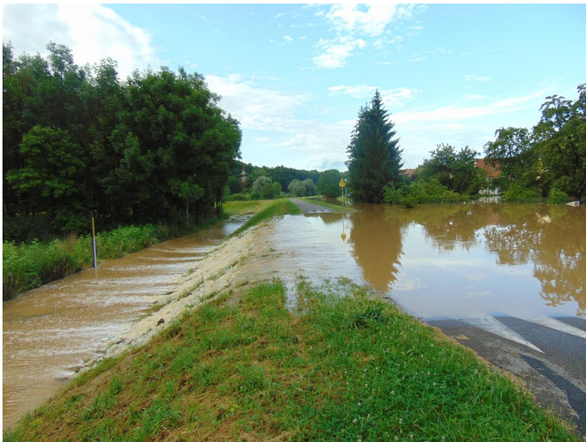
Déversoir aval de la digue de l'Allan fonctionnant en sens inverse (25/06 entre 6 et 7h)
