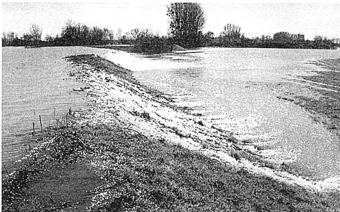
La digue de Charnay-lès-Chalon : elle a résisté un temps à la crue, mais a fini par céder
