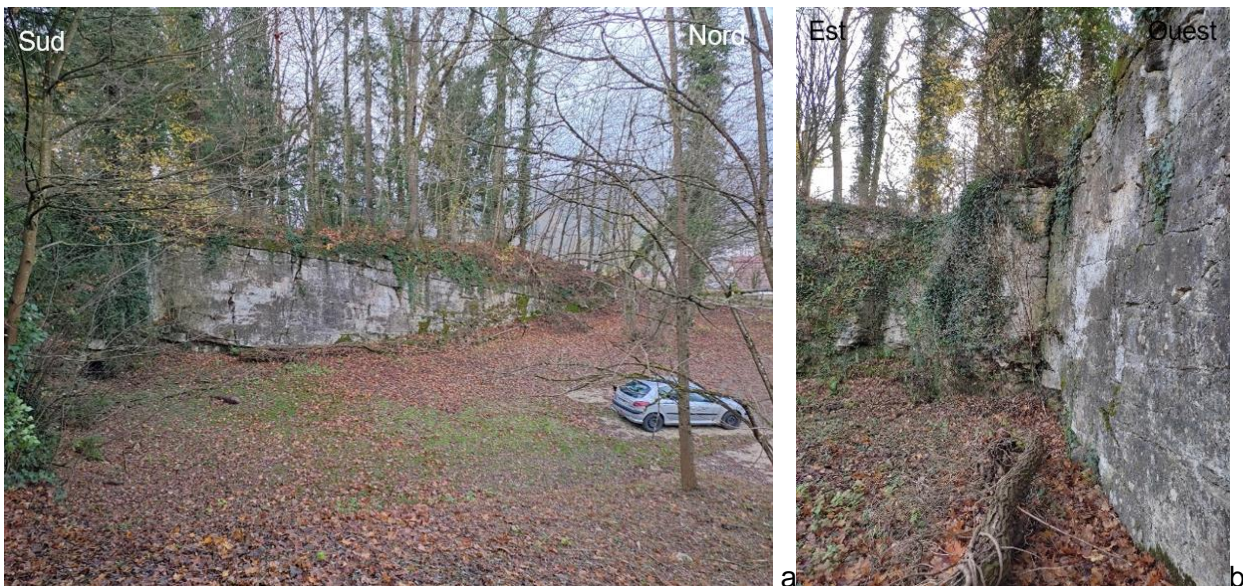
Figure 31 : a. Diaclase N-S observée au point d'affleurement N012. b. Plan de la diaclase en surface structurale. Affleurement situé au niveau du parking de l'église de Noivillars.
