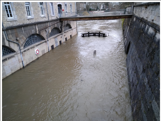
Écluse du moulin Saint-Paul inondée par le Doubs le 30 janvier 2021 à Besançon
