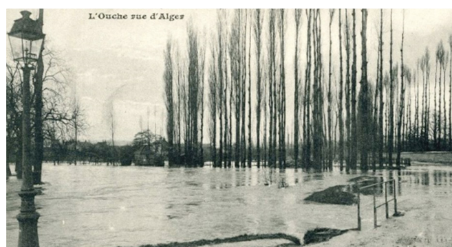
A Dijon, la rue d'Alger est sous les eaux de l'Ouche avec environ 80 cm à 1m d'eau (Archives municipales de Dijon)
