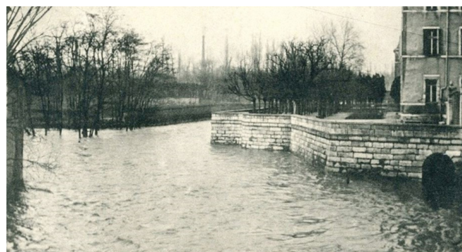
L'arrière de l'Hôpital de Dijon, inondé par les eaux de l'Ouche (Archives municipales de Dijon)
