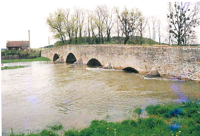
Pont Romain à Etrochey. Avec près de 2000 ans d'existence ce pont est considéré comme le plus vieux du département de Côte d'Or, un bel exemple d'aménagement prévu pour durer !
