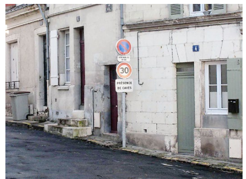
Figure 2 : panneau signalant l'existence de cavités sous la voirie communale (Cerema, 2012).
