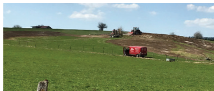
Entreprise réalisant des travaux à l'aide du casse-cailloux © Collectif pour les Paysages du massif jurassien
