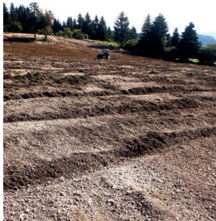
Travaux lourds au casse-cailloux © Pierre-Marie Aubertel
