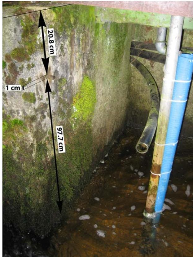
**Figure A.2 : Photographie de la « station CHYN ». Le point de référence est la vis de 1 cm de diamètre à 20.8 cm du bord. Le niveau d'eau de référence  $H_0$  de l'équation de tarage se trouve à 97.7 cm sous la vis.**
