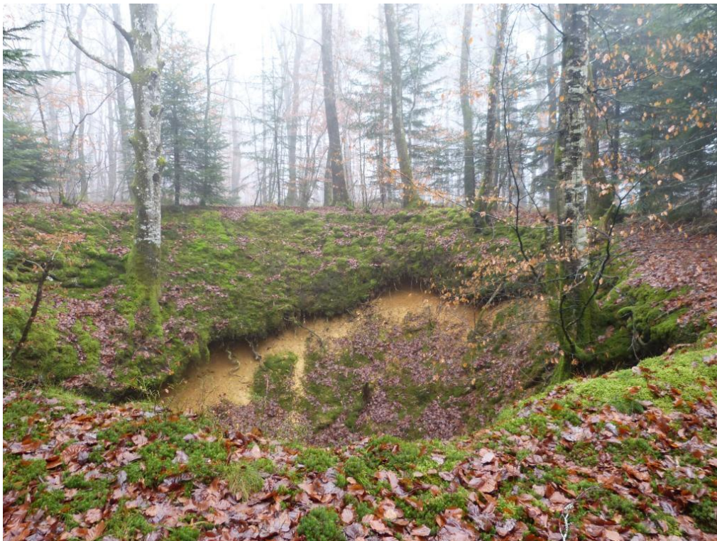
Illustration 6 : vue de l'entonnoir dans la forêt (photo BRGM)
