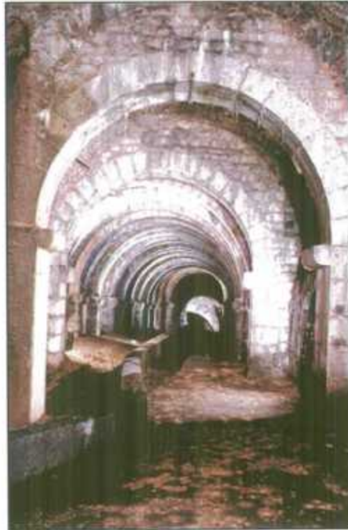
Figure 19 - Galerie souterraine des salines de Salins-les-Bains
