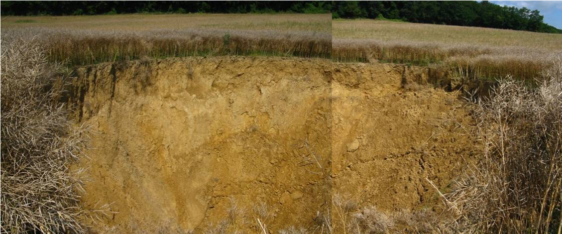
Illustration 11 – Effondrement d'une vingtaine de mètres de diamètre sur une dizaine de mètres de profondeur survenu en juillet 2007 sur la commune de Courcuire
