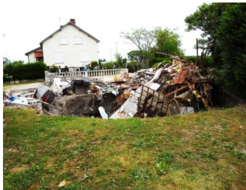
Figure 10 : Effondrement d'une habitation suite à l'apparition d'un fontis, St-Pryvé-St-Mesmin, 22 mai 2010
