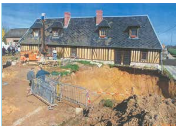
Illustration 1.30 : Effondrement, Neuville-sur-Authou (27) [crédit Cerema Normandie-Centre, 2001]
