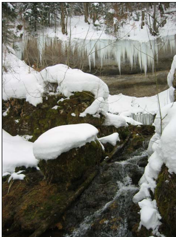
Photo 15 : Chute d'eau à la source de la Reverotte au droit d'une ancienne digue de moulin
