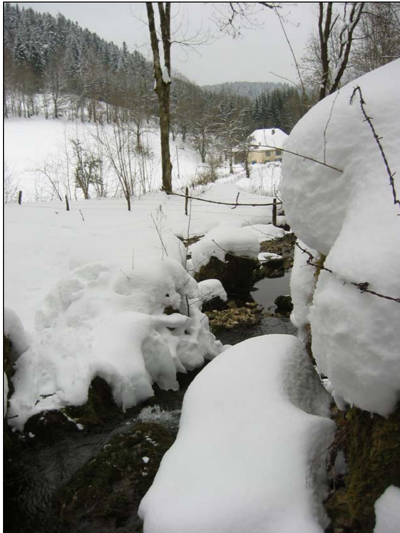
Photo 1 : Les Moulins de la Reverotte, installation située à l'aval de la source vue depuis la source de la Reverotte. Seul bâtiment non ruiné, possédant encore son canal d'améné.
