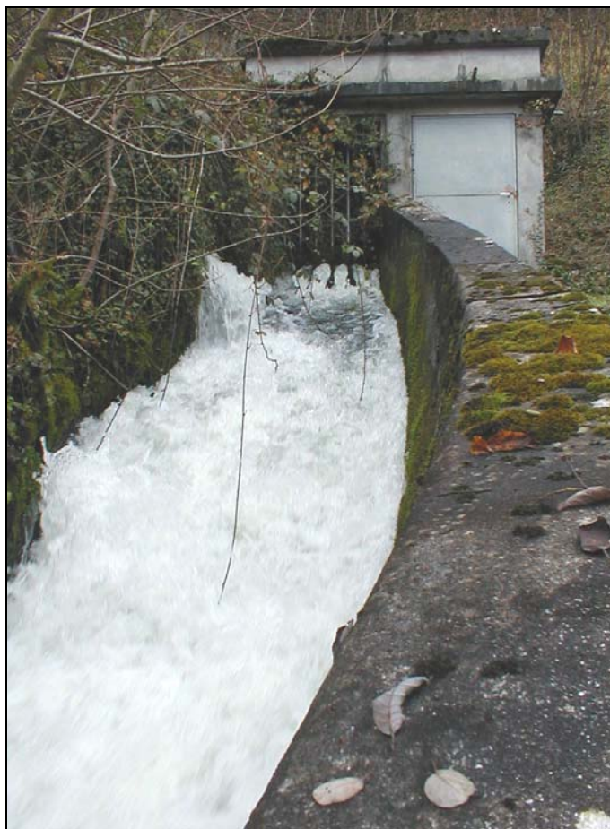
Photo 14 : Source de Plainmont en crue, un exutoire du système complexe Martivaux/Lavoir/Plainmont
