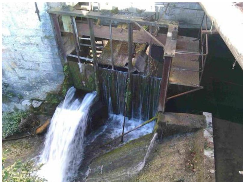
FIGURE 3.14 – Vue de la l'ouvrage régulant le niveau du Grand lac au niveau du pont d'Augeon
