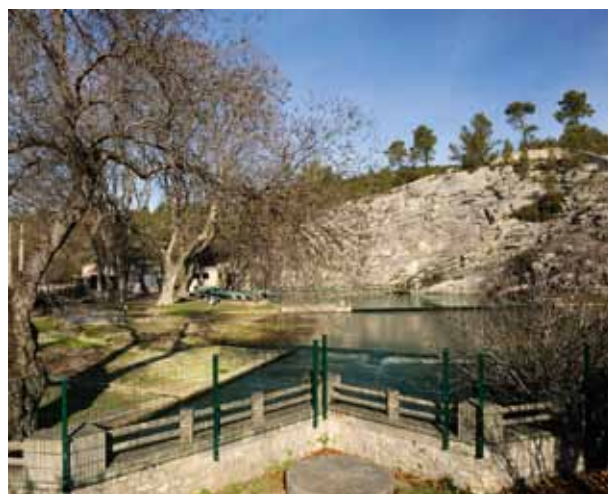
Captage de la source du Lez (Hérault) Captage de type B - Photo Philippe CROCHET
