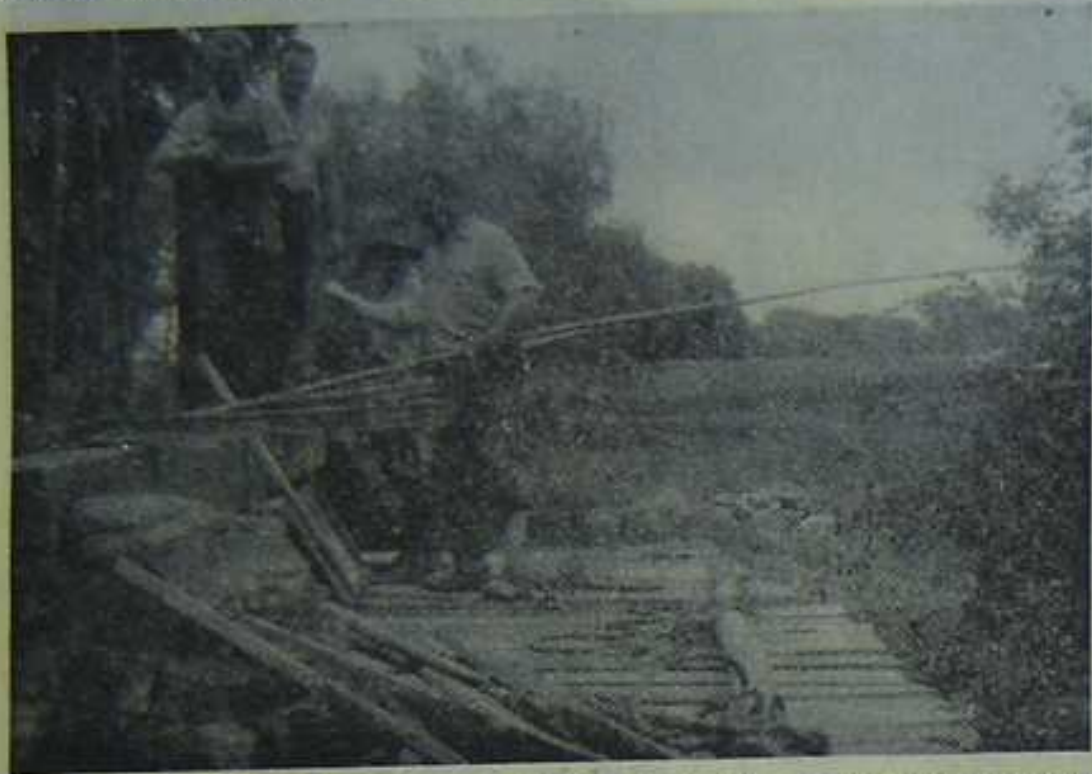
A COURLANS. — Après le désastre on colmate les brèches. Dans un autre moulin, à Condamine, les flots déchaînés ont emporté une partie du barrage. Le meunier et ses aides s'activent à colmater la brèche.
