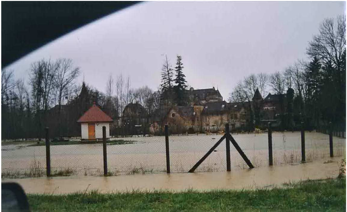
Secteur de la station de pompage, sous le château
