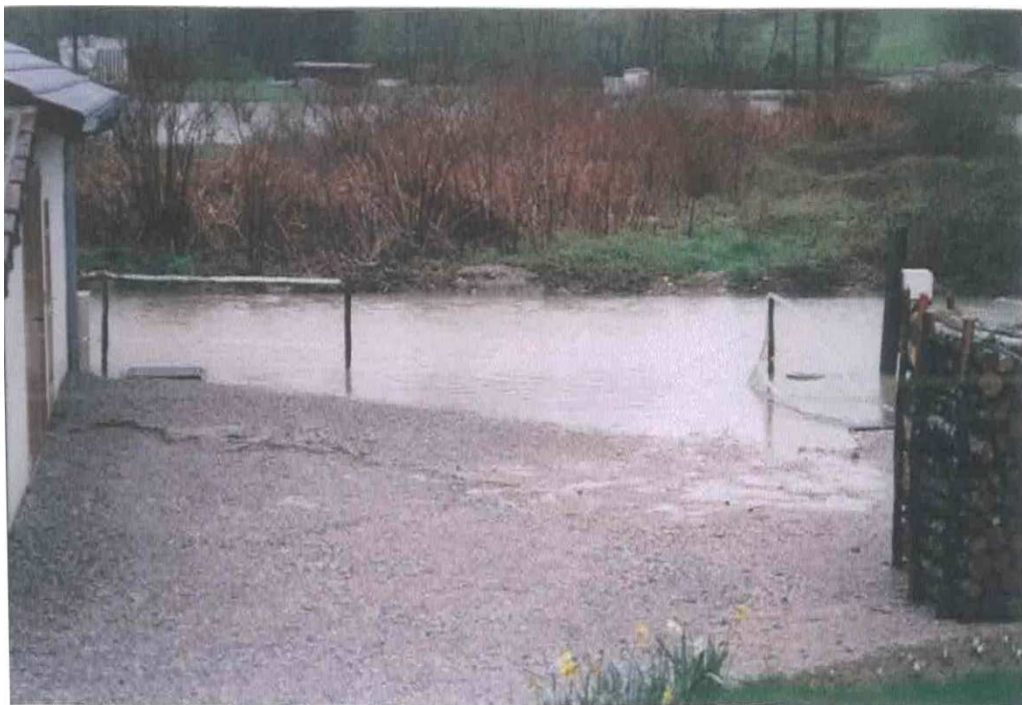
Vues sur la cuvette qui se forme devant le portail
