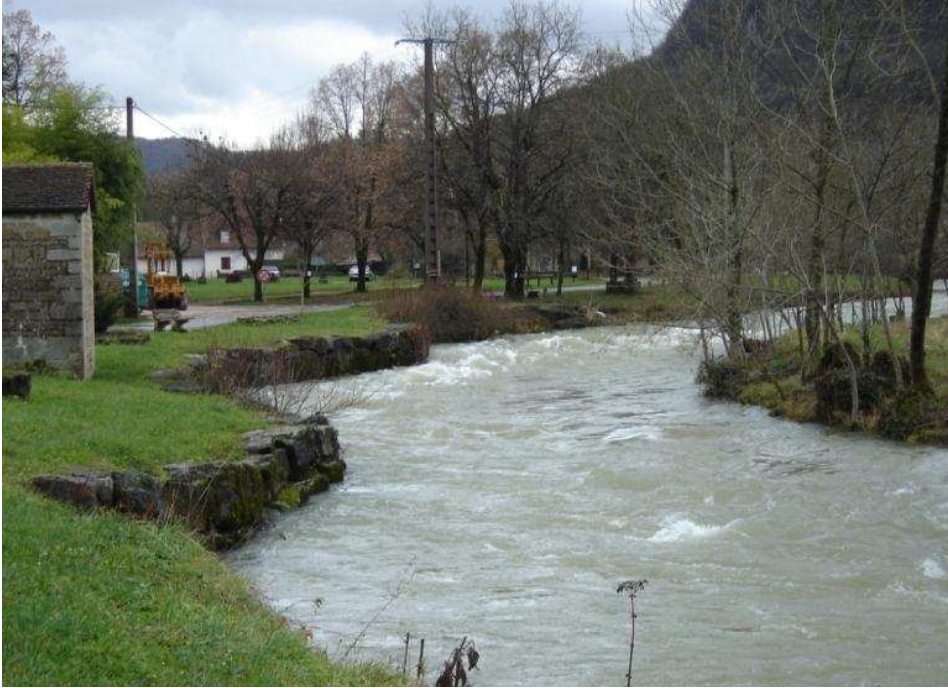
Vue au niveau de l'aval immédiat du pont du hameau BILLEN
