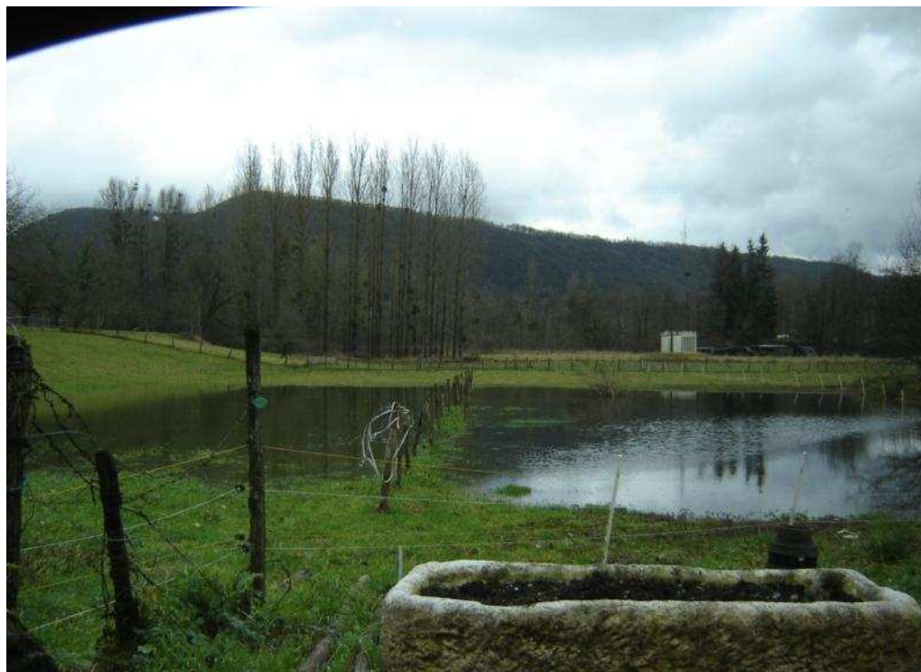
Vue sur la station de pompage
