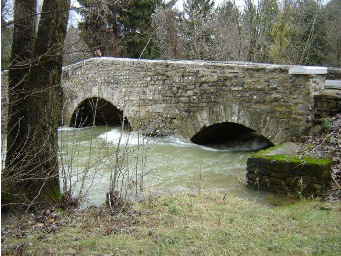
Pont sur RD 70 en limite NEVY / VOITEUR, vue d'amont vers l'aval
