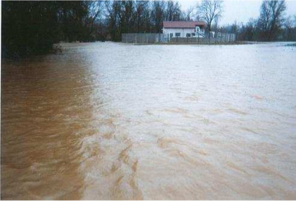
La station d'épuration
