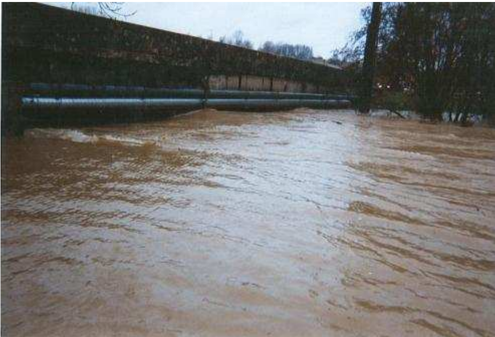
Vue depuis la cour de l'école vers la rive droite du pont de la rue de Corcelles
