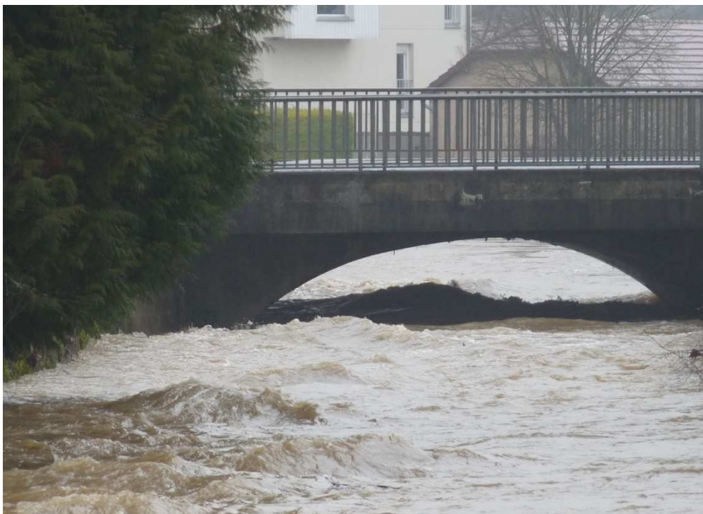
Vue depuis l'aval du pont de l'Hôpital
