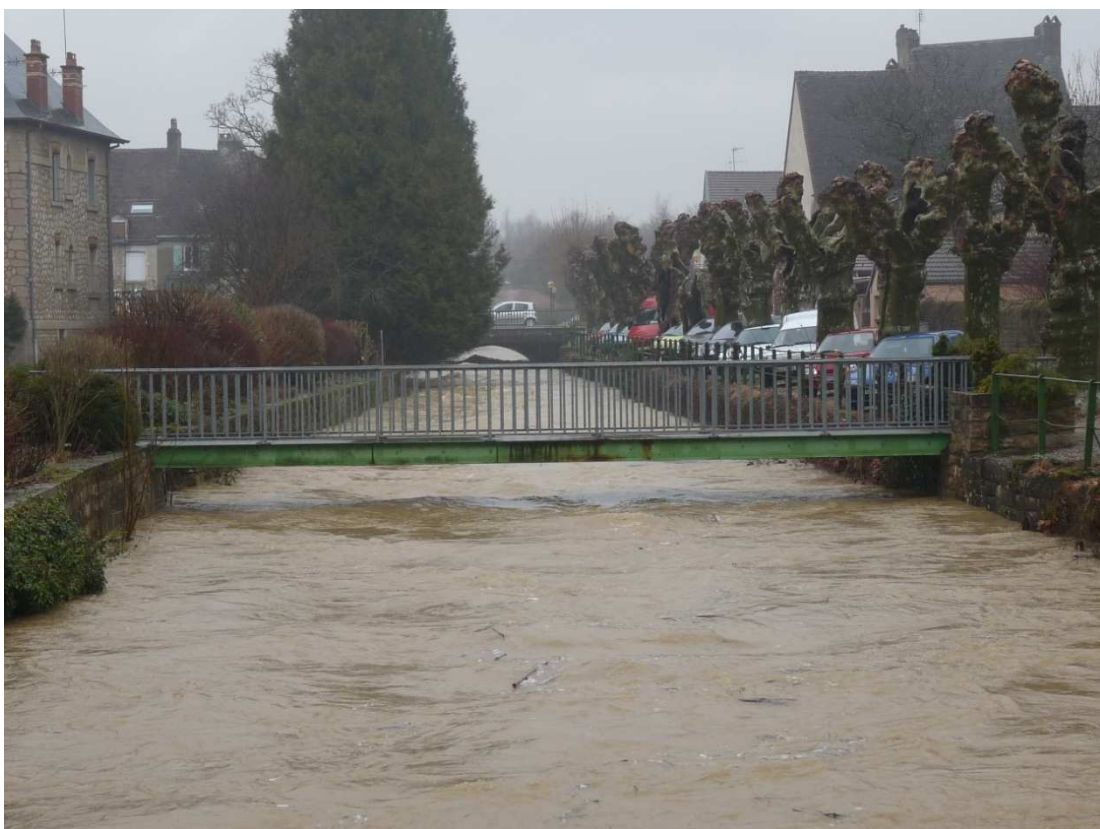
Vues depuis l'aval de la passerelle du foyer logement
