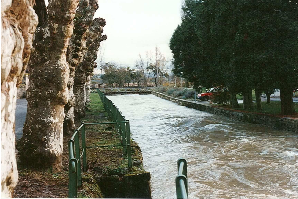
Vue depuis le pont de l'Hôpital vers la passerelle du foyer logement
