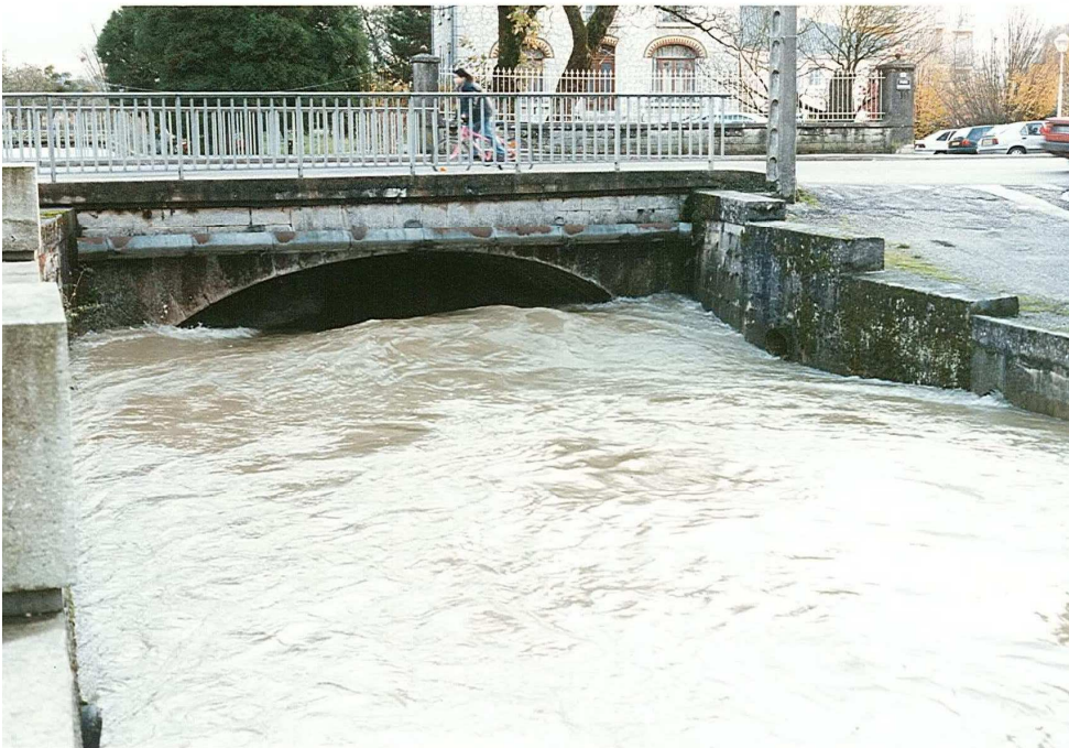
Vue depuis l'amont vers le pont de l'Hôpital
