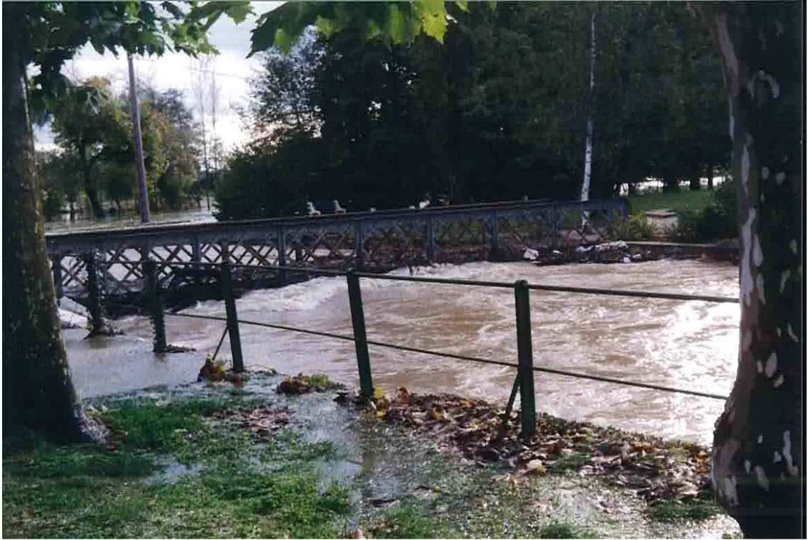
« La Seille en crue bute sur la passerelle vers le foyer-logement les Pâquerettes »
