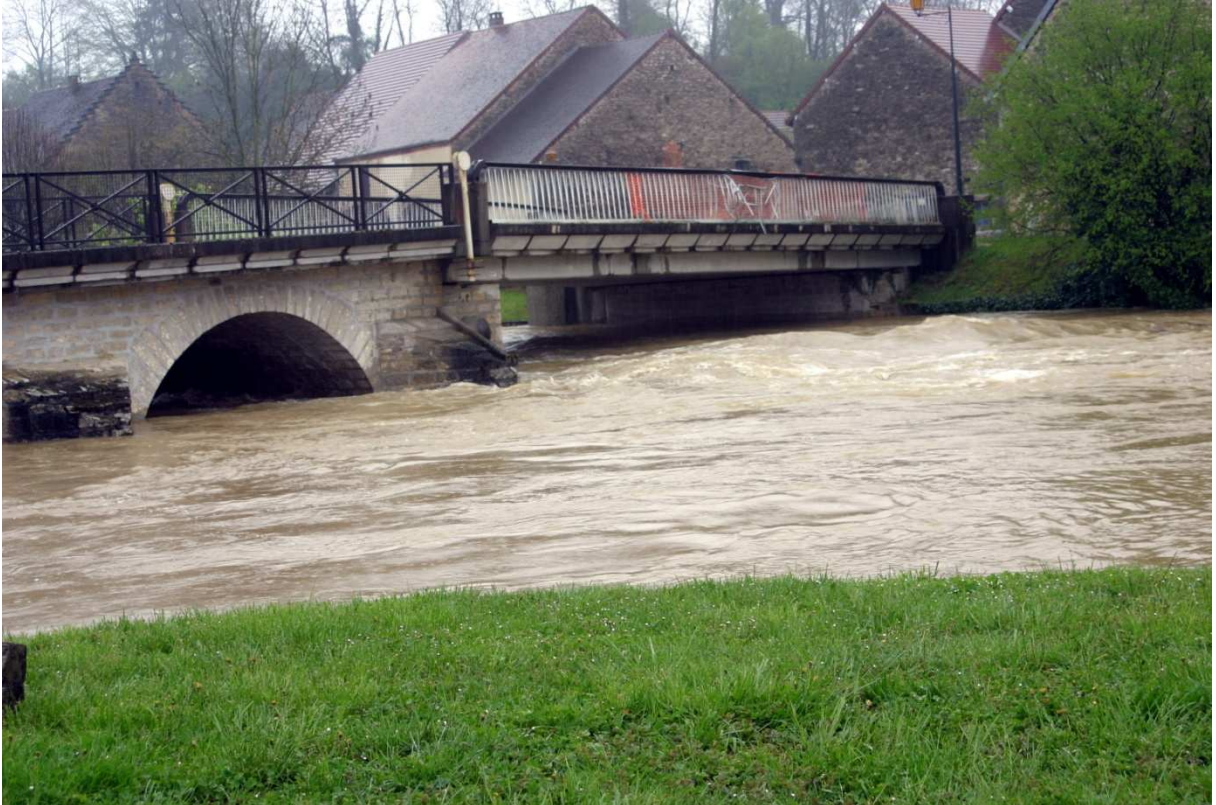
Pont de la rue Saint-Vincent : en sortie d'Arlay direction Bletterans, vue depuis l'aval
