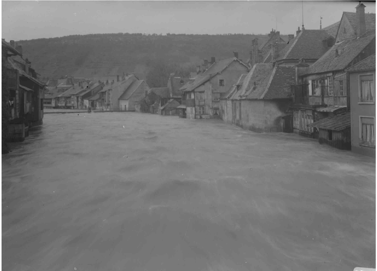
Vue de la Loue et de la Passerelle depuis le grand pont
