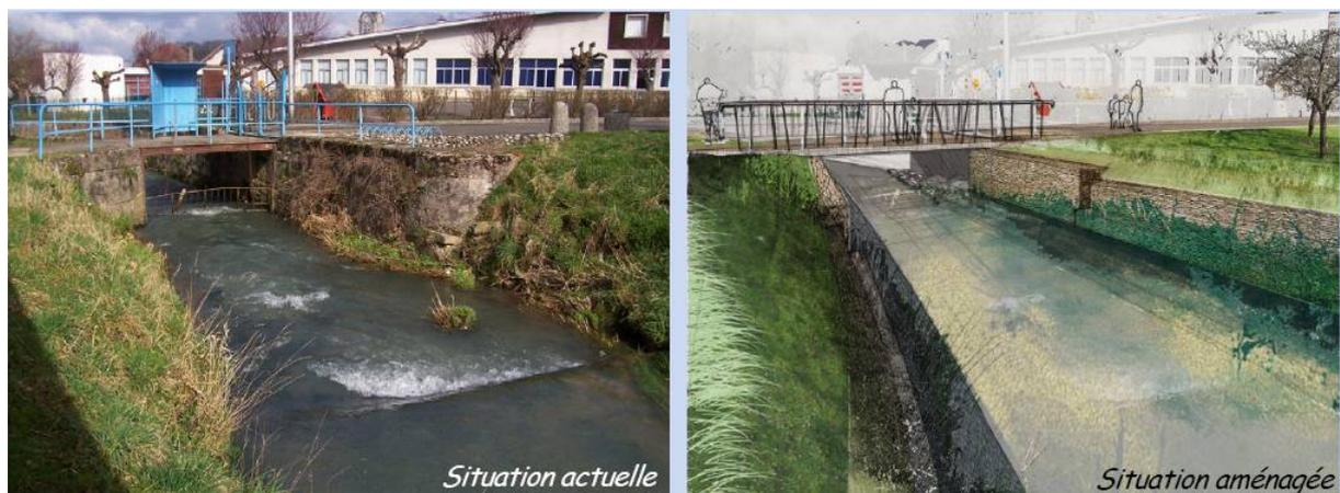
*Fig. 19 : La reconstruction des ponts et des passerelles. Les ponts et passerelles seront reconstruits pour être totalement « transparents » aux écoulements des crues. (Sources AB - CAPM 2007)*
