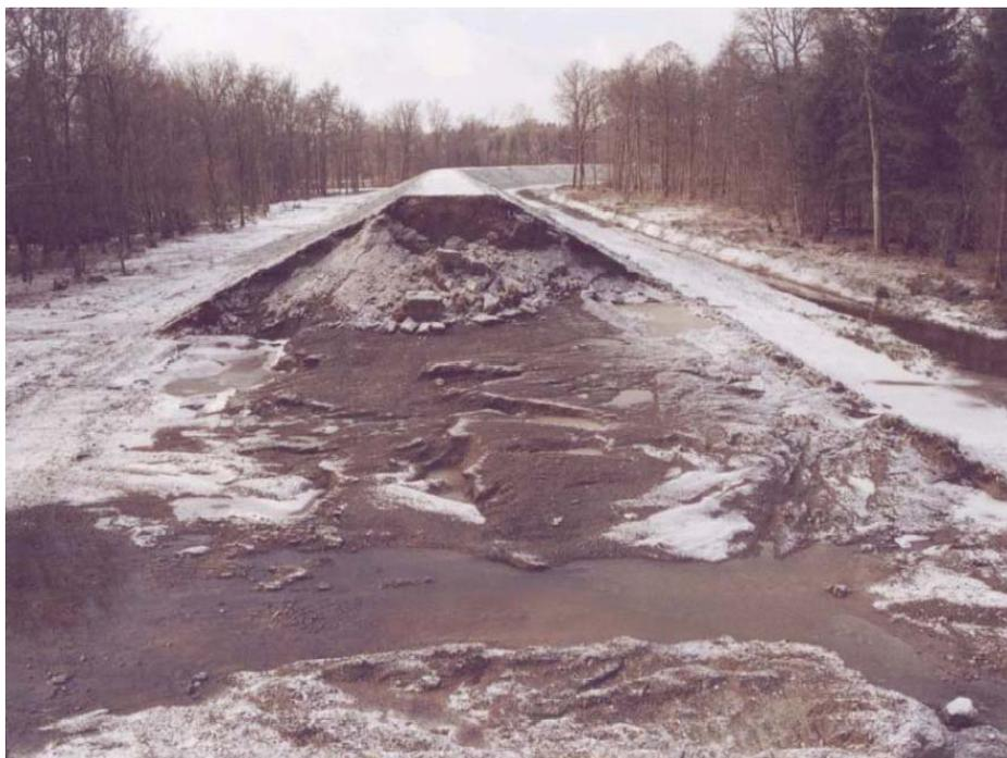
*Fig.3 La zone de rupture de la digue du bassin D3 le 30 décembre 2001*
