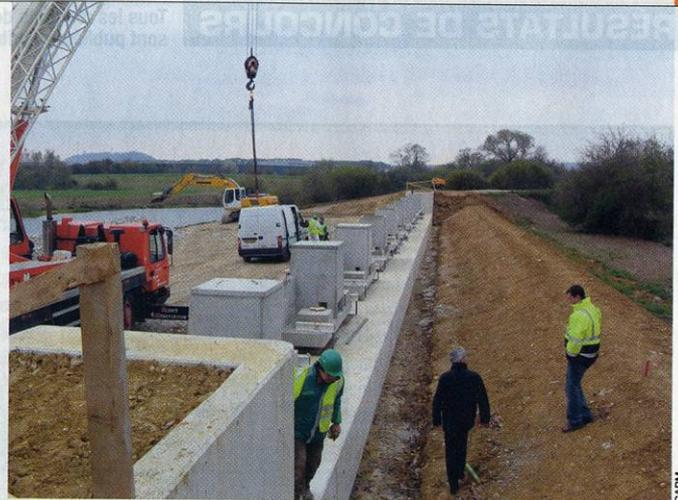
Pays de Montbéliard. Fabriquées en atelier, les hausses fusibles en béton armé de 5,50 mètres de long et 1,10 mètre de haut chacune basculent en séquence sous la pression de l'eau.
