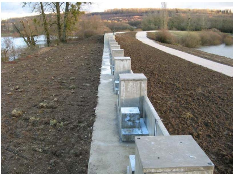
*Fig. 30 : La succession de hausses fusibles qui composent la digue.*
